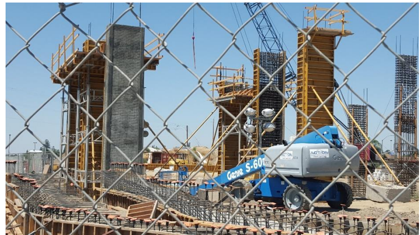
Santa Fe Pedestrian Grade Separation (Tulare, CA)
